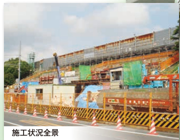
施工状況全景
