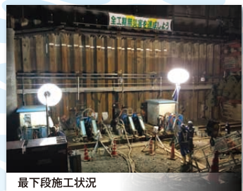
最下段施工状況
