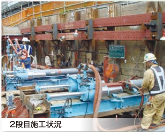
2段目施工状況
