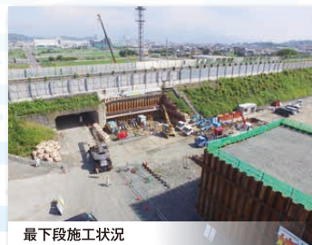
最下段施工状況
